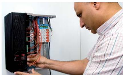
Снимите крышку с рэка 458 и подключите модуль(ли) управления серии 458.
